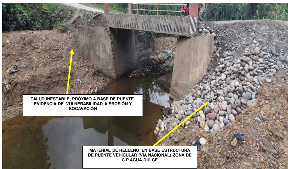
FIGURA N°03: VISTA DE INFRAESTRUCTURA VIAL (PUENTE) QUE SE ENCUENTRA VULNERABLE A EFECTOS DE EROSIÓN Y SOCAVACIÓN POR LA FUERZA DE ARRASTRE DE LA QUEBRADA AGUA DULCE
