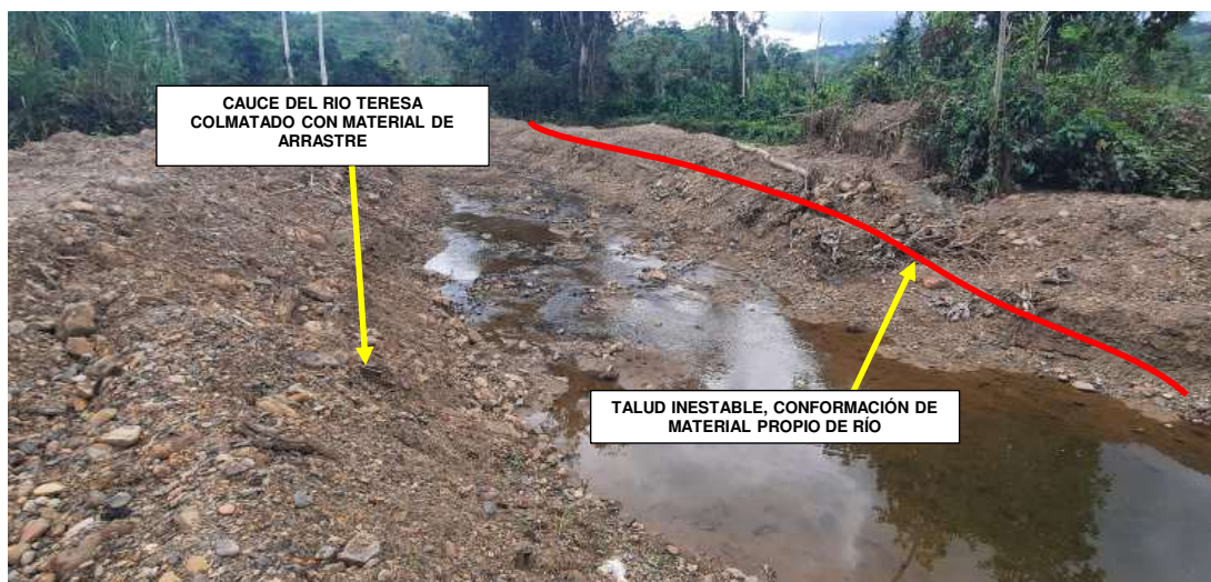
FIGURA N°01: TRAMO CRÍTICO EN LA QUEBRADA AGUA DULCE, EN EL SECTOR AGUA DULCE, DISTRITO DE UNIÓN ASHÁNINKA, PROVINCIA DE LA CONVENCIÓN - CUSCO. TALUD INESTABLE MARGEN IZQUIERDA DE EL RIO TERESA EN ZONA AGUA DULCE BAJA.
