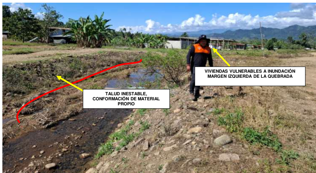
FIGURA N°02: VISTA DE VIVIENDAS EN LA MARGEN IZQUIERDA DE LA QUEBRADA AGUA DULCE (ZONA T-12) SECTOR AGUA DULCE, VULNERABLES A INUNDACIÓN.
